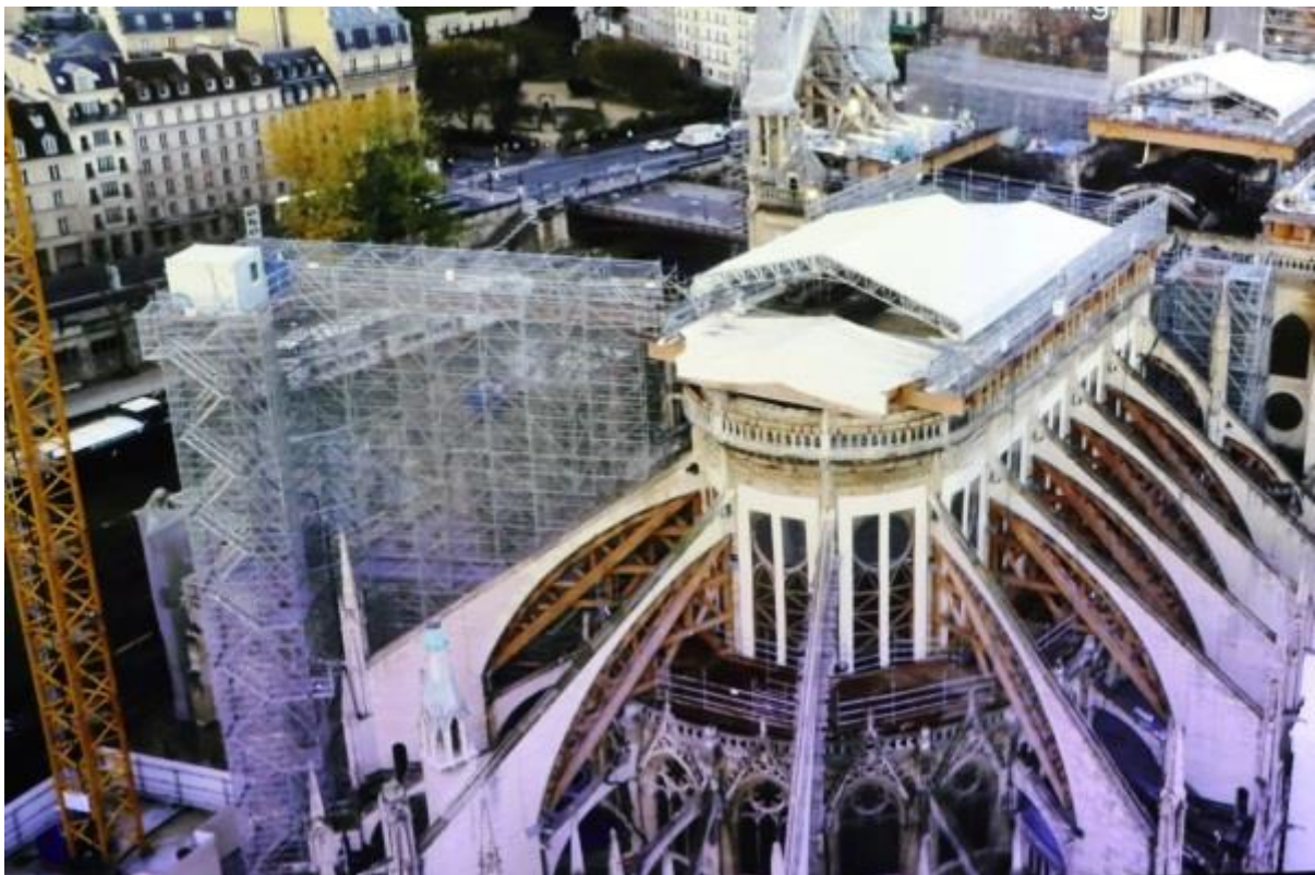
Sécurisation de l'édifice.
