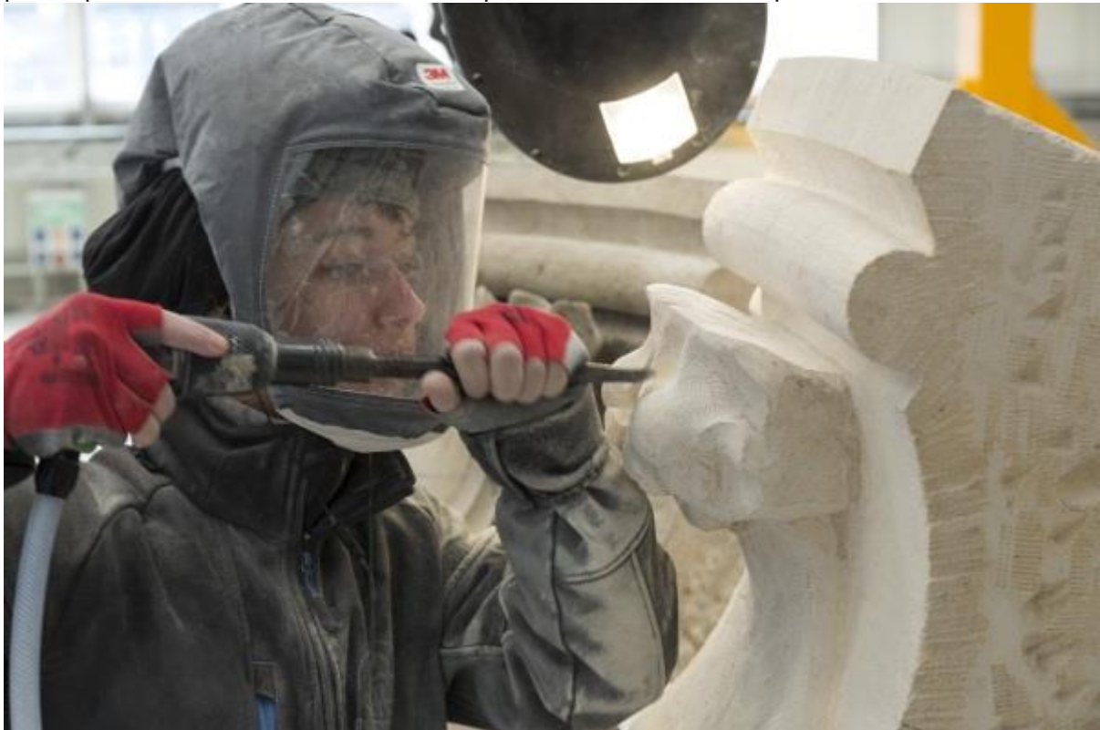
Les sculpteurs reproduisent les décors des pignons, tours et murs gouttereaux de la cathédrale que l'incendie avait abimés. © David Bordes / Etablissement public Rebâtir Notre-Dame de Paris.
