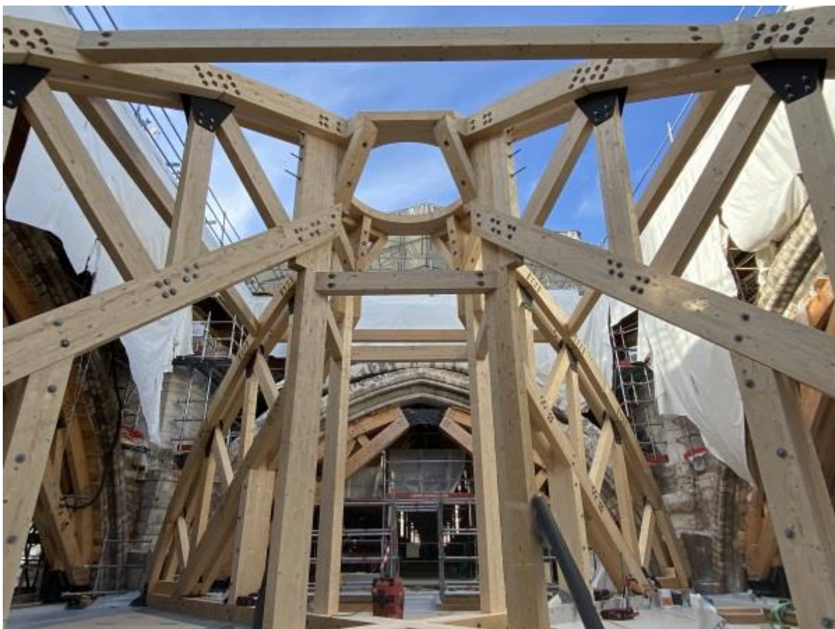
Pose des cintres qui serviront à reconstruire les arcs de la voûte à la croisée du transept.
