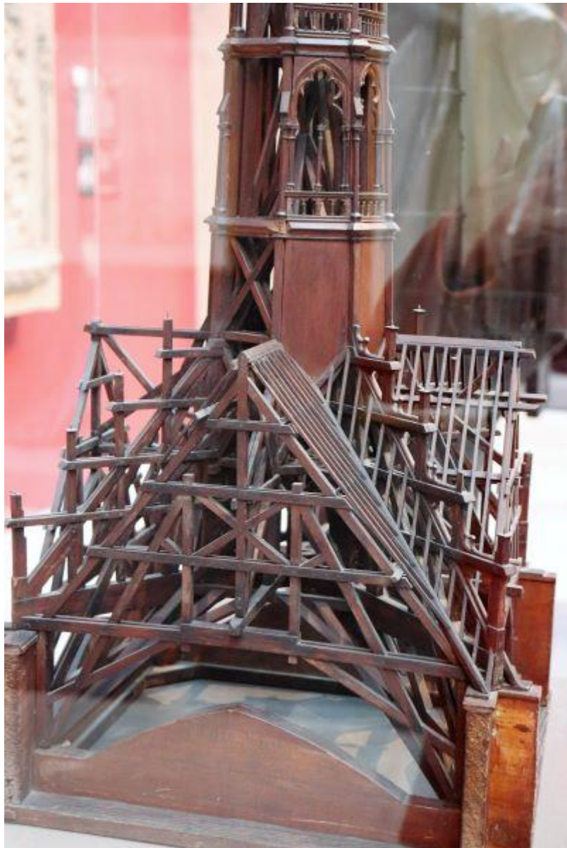
Maquette ancienne des charpentes flèche et transept.
