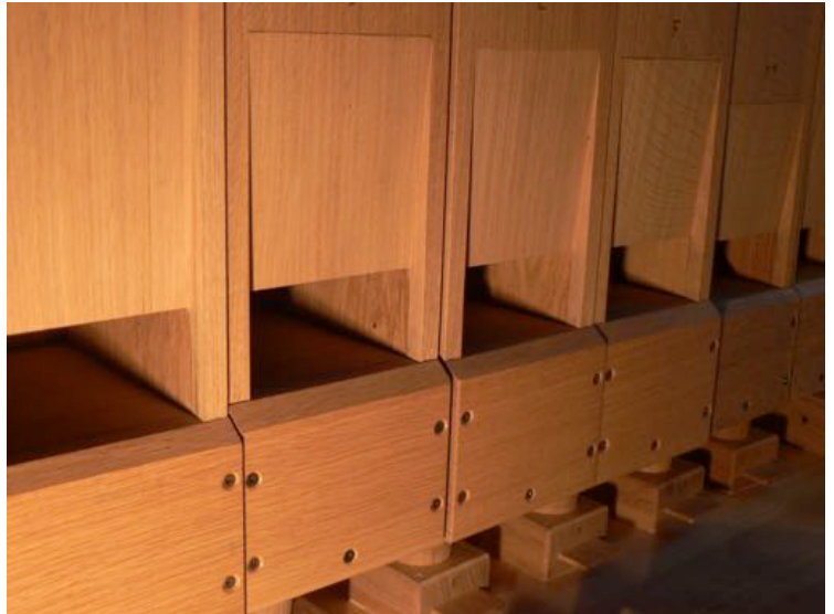
Reims, St Remi – Bouches de tuyaux en bois
